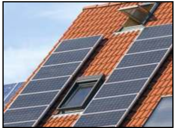
Plaques solars sobre el terrat d'una casa
